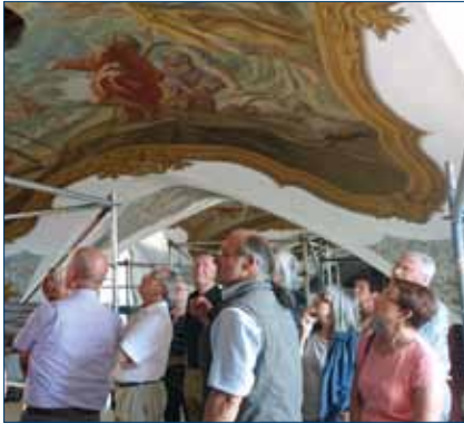
Baustellenbesichtigung | unter der Dachkuppel
