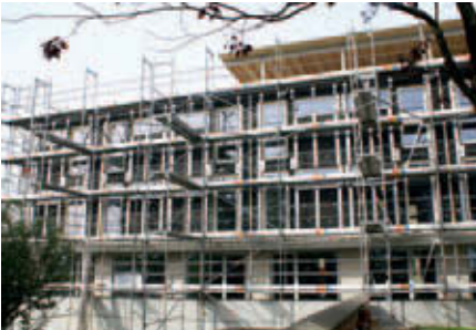
Südseite mit Gerüst
