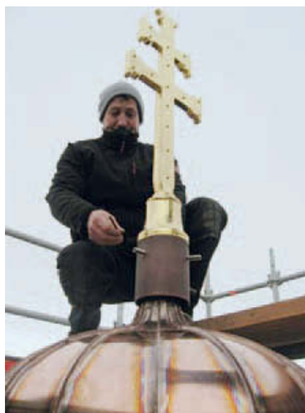
Aufstellen des neu renovierten Turmkreuzes
