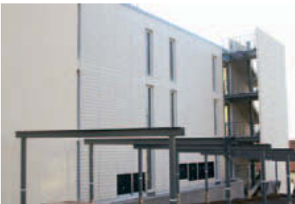
Nordseite ohne Gerüst
