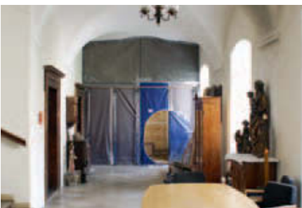
Durchbruch zwischen Alt- und Neubau
