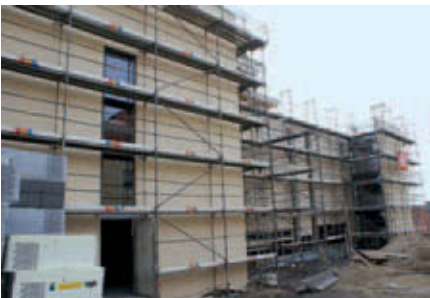
Nordseite mit Gerüst
