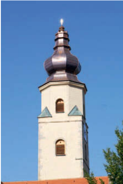
Die neue Turmhaube erstrahlt im neuen Glanz
