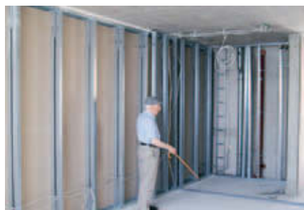
P. Roger kontrolliert die Baustelle
