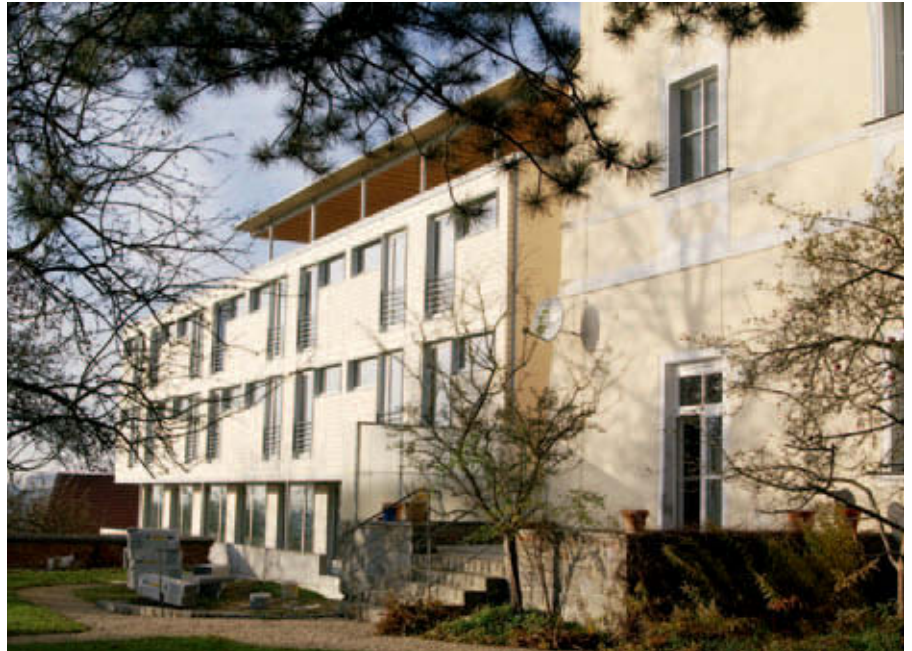
Südseite ohne Gerüst
