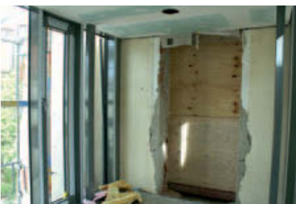
Durchbruch zwischen Neu- und Altbau
