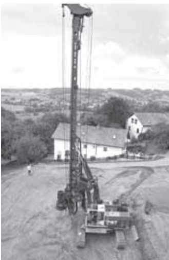
Bohrmaschine für die Betonpfähle
