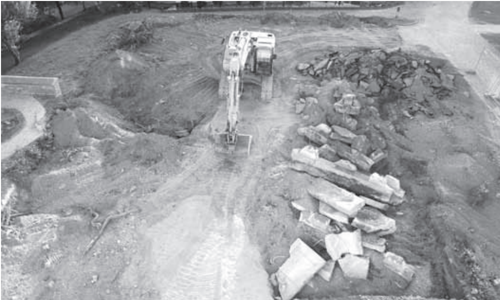
Die Bauarbeiten beginnen
