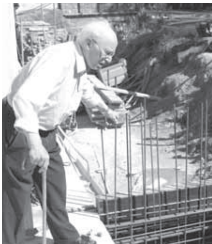
P. Roger kontrolliert die Bauarbeiten...
